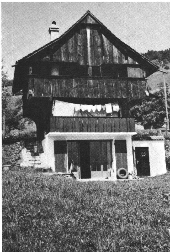
A droite: Un grenier de l'Emmental parachuté en Obwald et aménagé en chalet de week-end est du «Heimatschutz» très mal compris.
