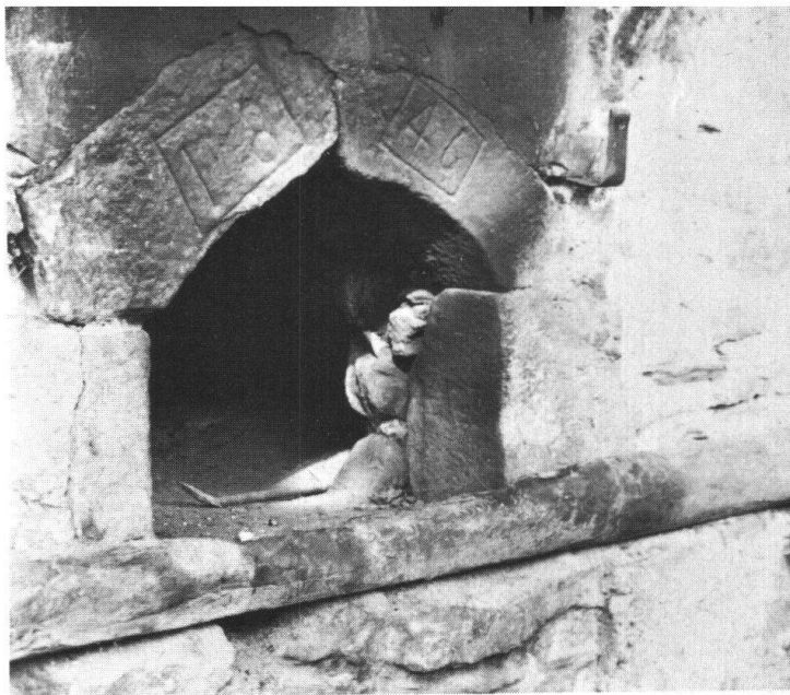
En haut: La flamme du four banal des Arlaches ne s'éteindra pas. – Ci-dessous: A côté de l'ancien bâtiment qui abritait le fournil, on a construit une nouvelle maisonnette où se trouve le four.
