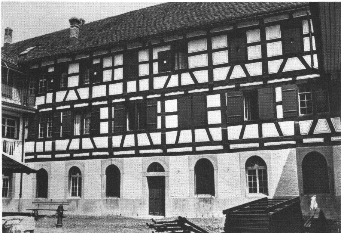
MAGDENAU SG. Zisterzienserinnen-Kloster. Die den Innenhof (Kreuzgang) umstehenden Gebäude sind grossenteils Riegelbauten. Unsere Bilder zeigen die Südseite des Innenhofes vor der Restaurierung mit dem verputzten Riegelwerk und die Nordseite nach der Restaurierung mit dem freigelegten und instandgesetzten Riegelwerk. Photos: Eidgenössisches Archiv für Denkmalpflege, Zürich
