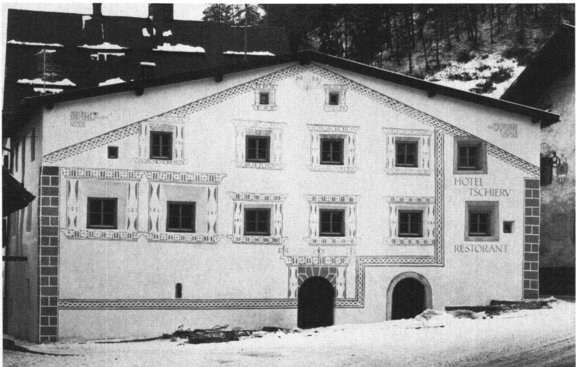
MÜSTAIR GR. Hotel Hirschen vor und nach der Restaurierung. Das den Platz Grund massgeblich prägende Gebäude ist im ersten Drittel unseres Jahrhunderts umgebaut und mit einem turmartigen Aufbau versehen worden. Bei der Fassadenrestaurierung von 1974 entdeckte man eine originale Sgraffitodekoration von 1613, welche wiederhergestellt wurde und die Rekonstruktion der ursprünglichen Fensterdisposition gestattete. Auf die ursprüngliche Dachneigung, die von der Dekoration markiert wird, konnte man aus Nutzungsgründen nicht zurückgehen. Photos: M. Burkhardt, Müstair
