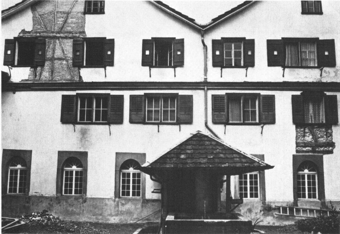
MAGDENAU SG. Zisterzienserinnen-Kloster. Die den Innenhof (Kreuzgang) umstehenden Gebäude sind grossenteils Riegelbauten. Unsere Bilder zeigen die Südseite des Innenhofes vor der Restaurierung mit dem verputzten Riegelwerk und die Nordseite nach der Restaurierung mit dem freigelegten und instandgesetzten Riegelwerk. Photos: Eidgenössisches Archiv für Denkmalpflege, Zürich
