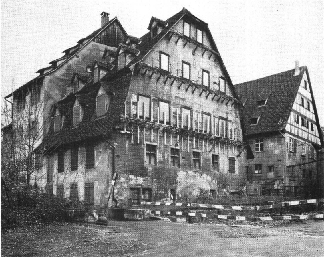
Basel. Albantal. Alte Hammerschmiede (links) und Rychemühle. Im Vordergrund abgeschrankt das Areal der abgebrannten Stegreifmühle, die wiederaufgebaut werden soll
