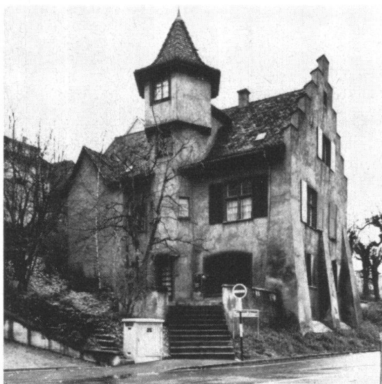
Binningen. Holec-Schlössli vor der Restaurierung
