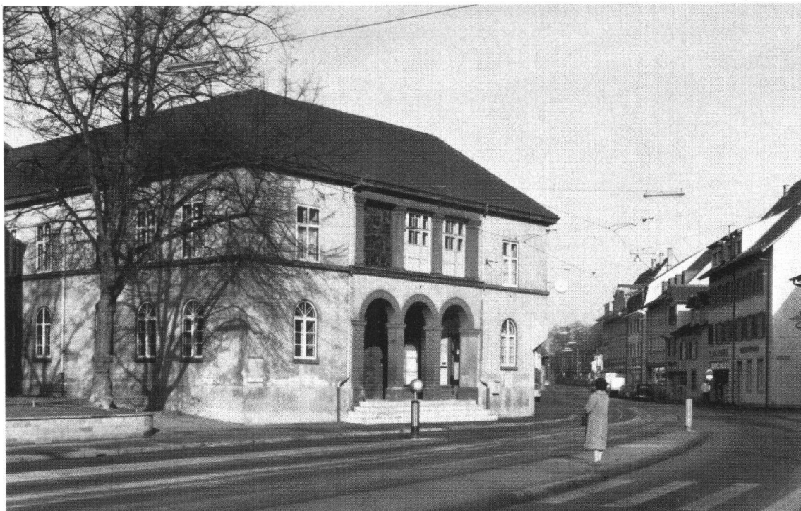
Riehen, Dorfplatz. Altes Gemeindehaus von Melchior Berri, vor der Restaurierung
