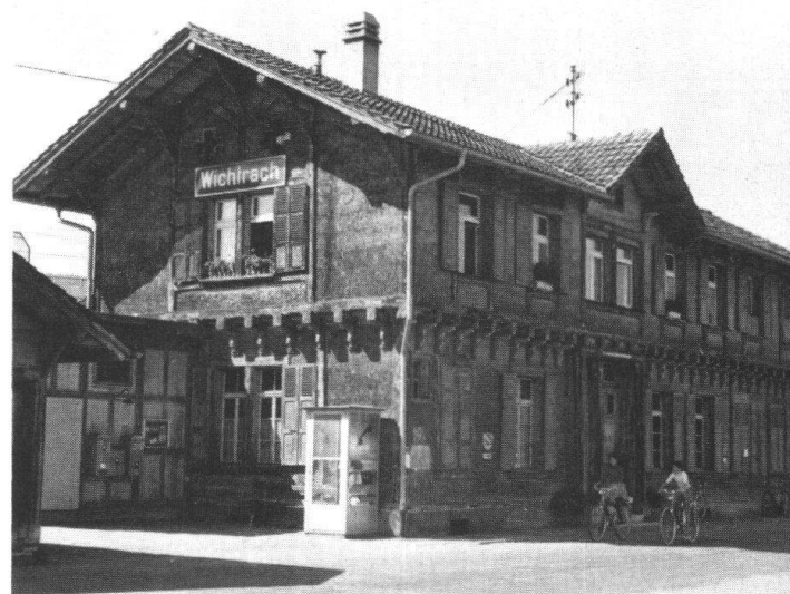
Das Stationsgebäude von Wichtrach, 1859 von Ludwig Maring gebaut, ist heute vom Abbruch bedroht.
