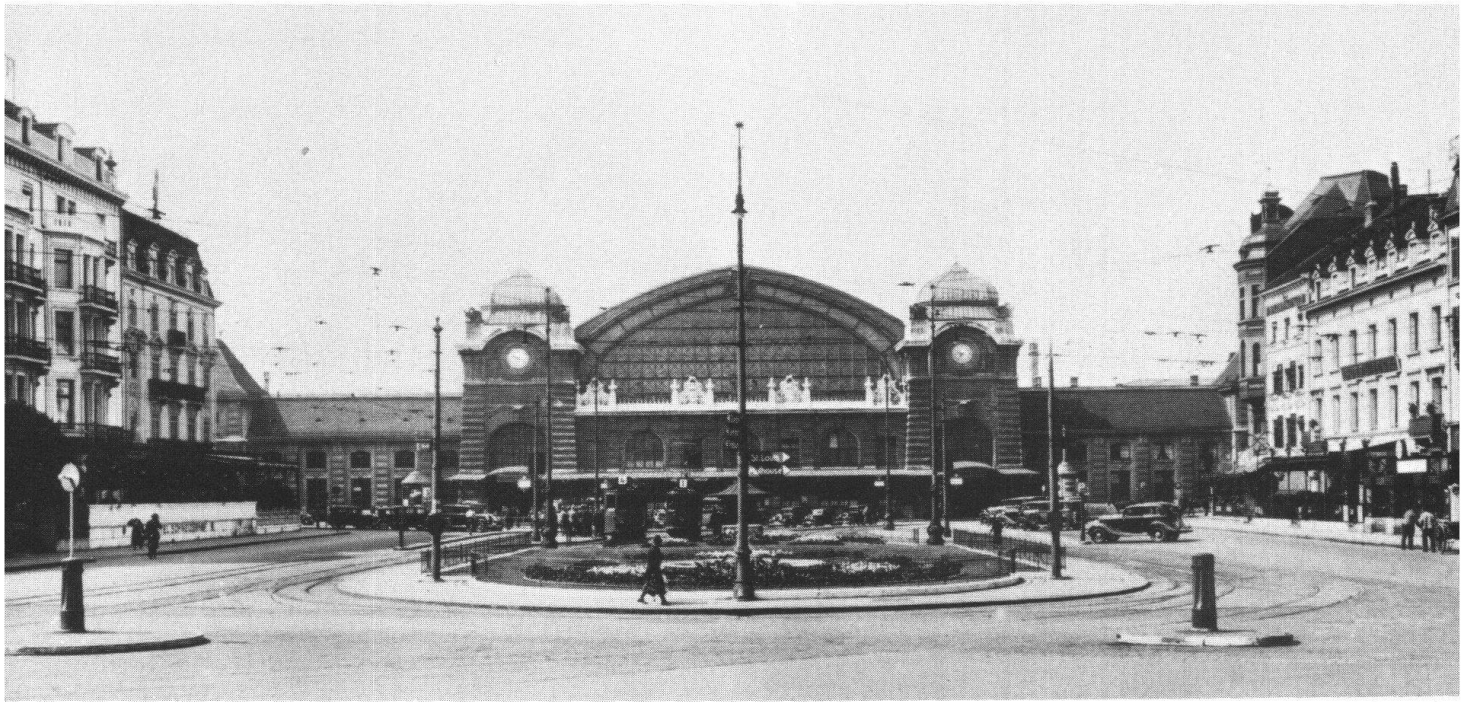
La gare CFF de Bâle, avec son énorme verrière à armature métallique, fut terminée en 1907, conformément aux plans d'Emile Faesch (1865–1915) et Emmanuel La Roche (1863–1922).
