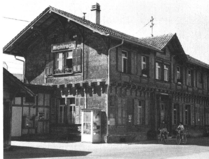
La gare de Wichtrach, construite en 1859 par Ludwig Maring, est menacée aujourd'hui de démolition.
