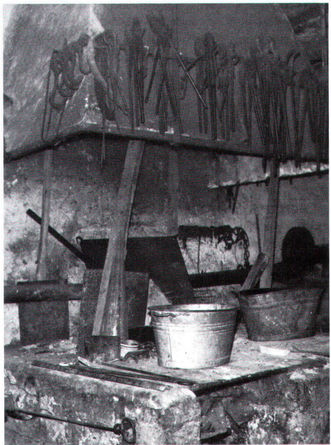
Schmiedeidylle: Hier soll demnächst wieder schöpferisch gearbeitet werden. (Bild SHS)
