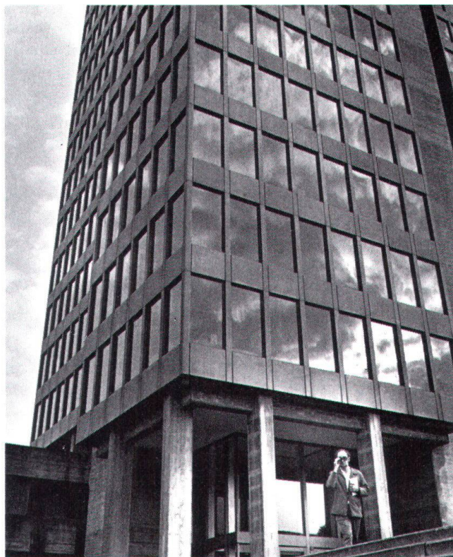
Klimatisieren von Arbeitsräumen muss überall dort als unnötige Energieverschwendung bezeichnet werden, wo man die Gebäude ebensogut natürlich belüften könnte (Bild Schneider).
