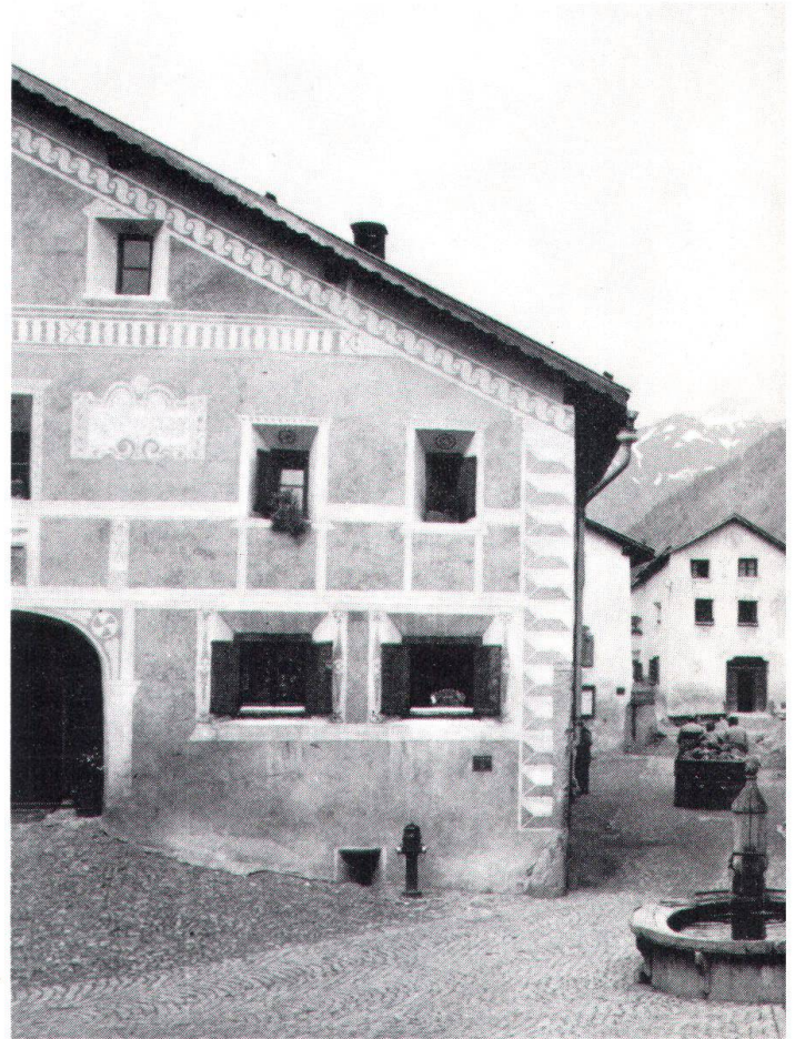
Murs épais, petites fenêtres dans les régions de montagne, construction de bois, orientation de la maison au soleil – nos ancêtres étaient des bâtisseurs attentifs à l'énergie. Ils ont encore beaucoup à nous apprendre (photo SHS).
