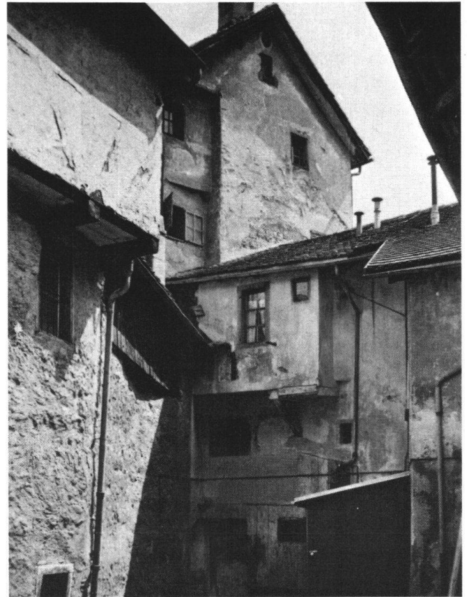
Durch ein umfassendes Sanierungsprojekt konnte das Churer Altstadtquartier «Arcas» einer breiteren Öffentlichkeit zugänglich gemacht werden. Die beiden obigen Bilder zeigen eines der Häuser am Bärenloch vor und nach der Renovation (Bilder Schuler/Hartmann).
