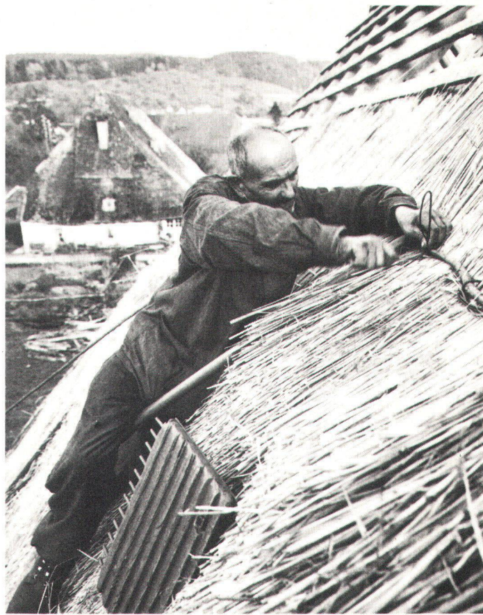
Nach dem Brand musste das Strohdach wieder fachgerecht repariert werden (Bild Boog).
