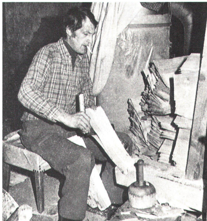
Le fabricant de bardeaux de Grandvillard (FR) au travail (photo: Section vaudoise des monuments historiques). Photo du haut: toit d'alpage à la Valsainte (FR).
