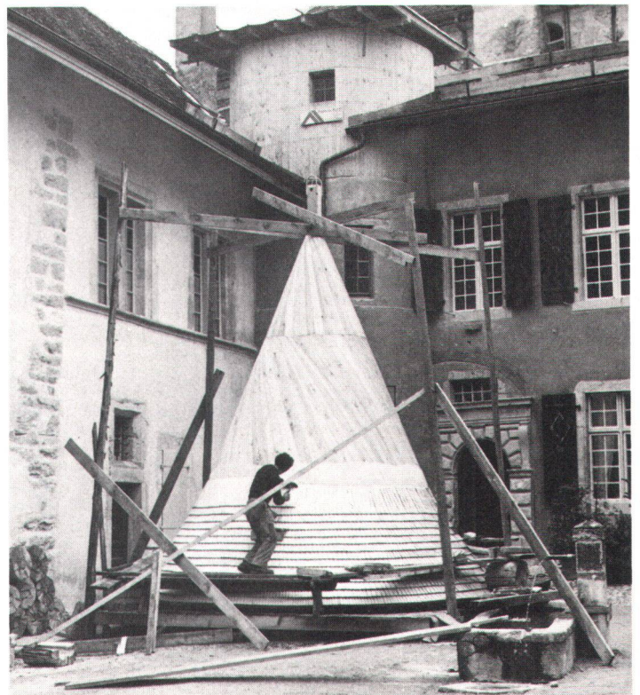
Reconstitution du toit tavillonné de la tour d'entrée de la Maison du Prieur.
