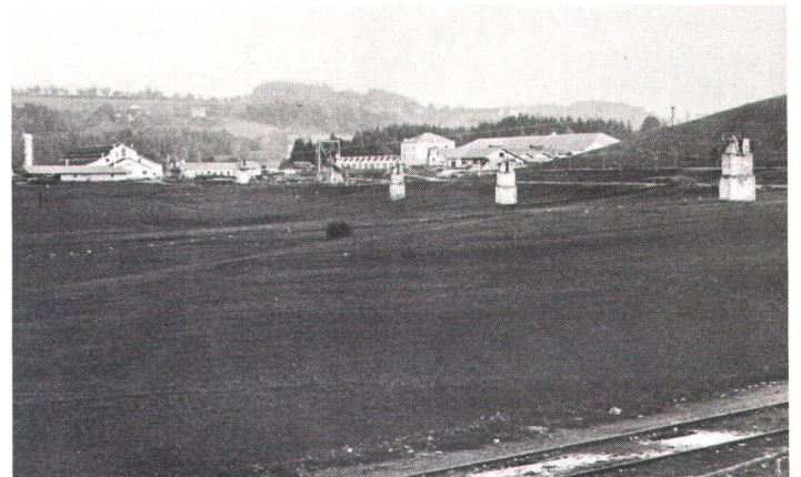
Péroilles FR vers 1875, avec transmission téléodynamique de l'énergie hydraulique (photo A. P. I.).
