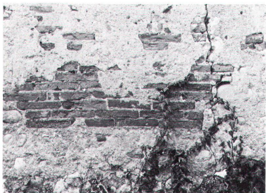
Le crépi à la chaux traditionnel tient plus longtemps sur la pierre (parties claires) que sur la brique (photo Baertschi).
