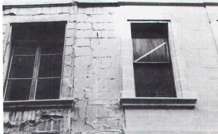
Façade de pierre avant et après sa restauration (ph. Baertschi) Steinfassade vor und nach der Restaurierung
