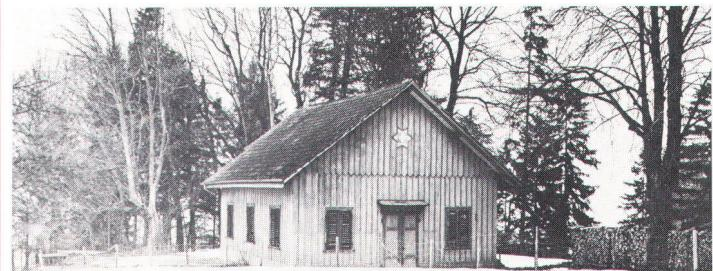
Oben: Senkrecht verschalte Fassade mit Deckleisten der Metron-Siedlung in Windisch. Unten: Gleiche Verschalung an einem alten Schützenhaus in Wellhausen TG (Bilder Stähli)
