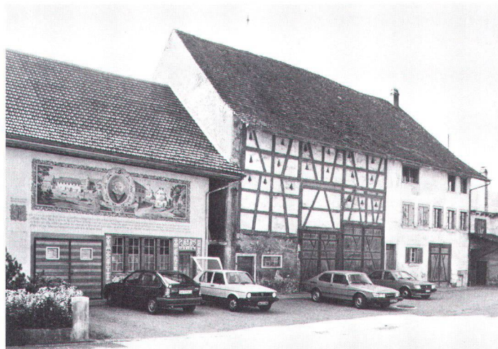
Embrach ZH: Erosion bäuerlicher Strukturen (Bild Stähli) A Embrach ZH: érosion d'une structure architecturale paysanne.
