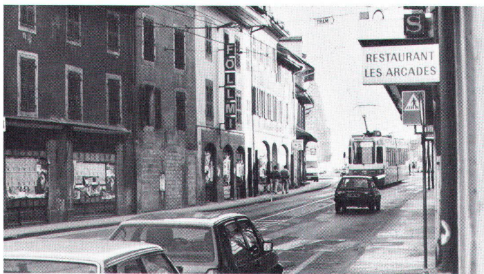
La rue de Genève doit être pourvue d'une seconde voie de tram et élargie – mais à quel prix? (photo Baertschi).
