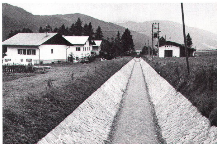
Arme Natur! Mit starrem, undurchlässigem Trapezprofil kanalisierten Bach (Bild Weiss)
