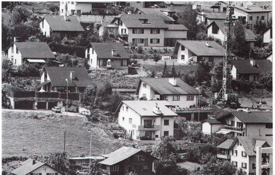
Einfamilienhausweise irgendwo im Mittelland (Bild Siffert) Types de maisons individuelles du Plateau suisse.
