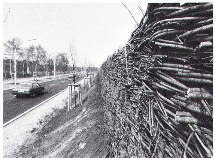
Biologische Schutzmauer aus Weidenpfählen und -geflecht in Norderstedt BRD (Bild Keystone).
