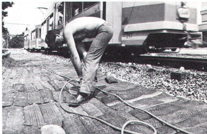
A Münchenstein BL, des pneus de voitures usagés front un coussin anti-bruit sous les voies de tram.
