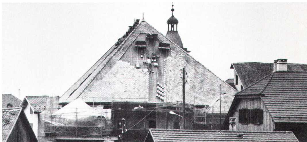
Im Frühjahr 1989 konnte die Deckenerneuerung abgeschlossen werden (Bild Bernard). C'est au printemps 1989 que la rénovation de ce toit a pu être achevée.
