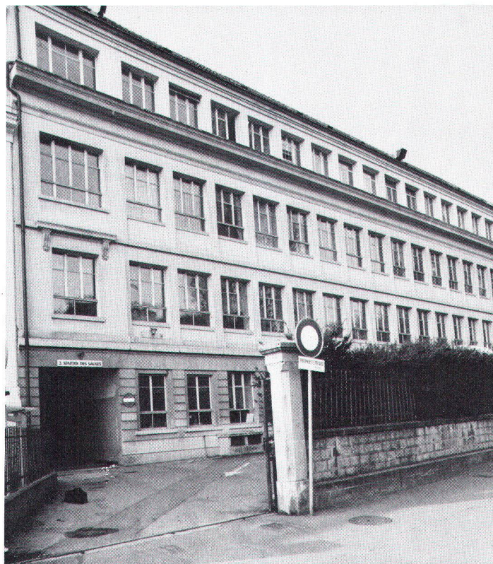
A la Jonction (Genève): naguère fabrique de cadrans Stern, aujourd'hui bâtiment administratif (photo Baertschi).
