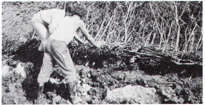
Quand l'ingénieur stabilise les rives avec des matériaux naturels (fascines de saule). Ingenieurbiologische Stabilisierung mit Uferfascine aus Weiden (Bild Zeh).
