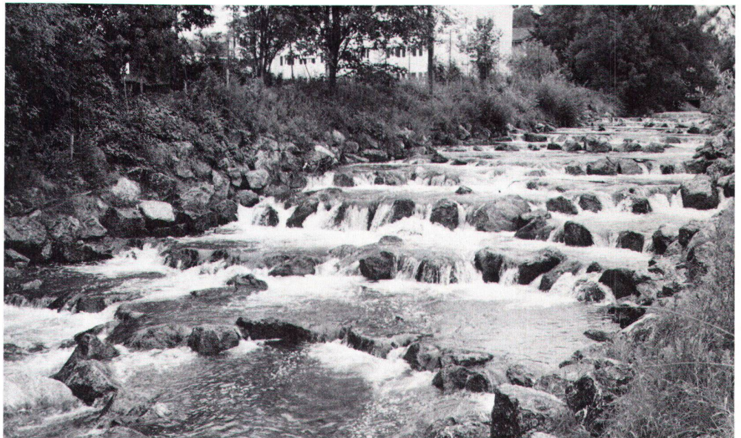
En ville aussi, de fortes chutes peuvent être maîtrisées avec des pierres naturelles. Grosse Abstürze lassen sich auch in der Stadt rückbauen (Bild Keller).
