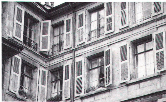
Fenêtres à verre simple dans une façade du Vieux-Genève. Fenster mit Einfachverglasung in einer Fassade der Genfer Altstadt (Bild Oettli).
