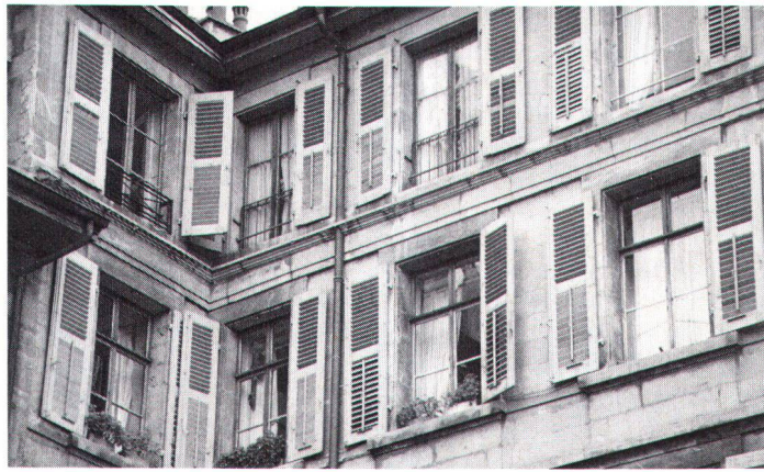
Fenêtres à verre simple dans une façade du Vieux-Genève. Fenster mit Einfachverglasung in einer Fassade der Genfer Altstadt (Bild Oettli).
