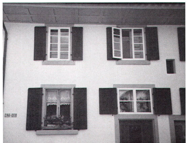
Der Einbau von Lärmschutzfenstern ist in vollem Gange (Bild Steger).
