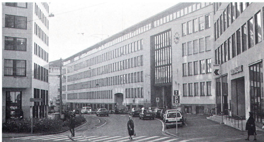
Spiegelhof in Basel, 1938/39 erbaut von Hans von der Mühll und Paul Oberrauch (Bild Jakob Hauser).
