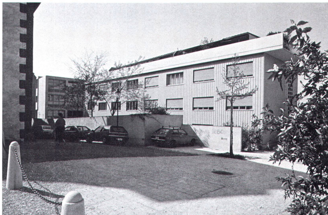
Neubau von Diener & Diener im Basler St.-Alban-Quartier (Bild Leemann).
