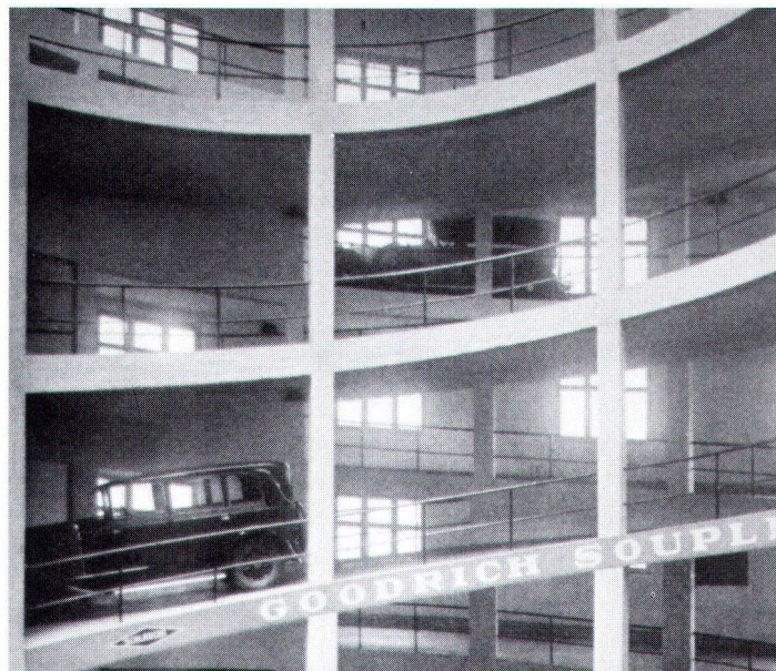
Rampenturm der Grossgarage Schlotterbeck (Bild SBZ).
