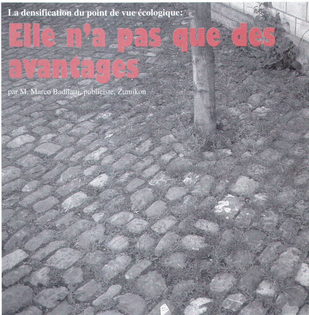
Pavage favorable, avec sa végétation, à l'infiltration des eaux. Sickerfreundliche Pflasterung mit Gras- und Baumwuchs (Bild Zeh).
