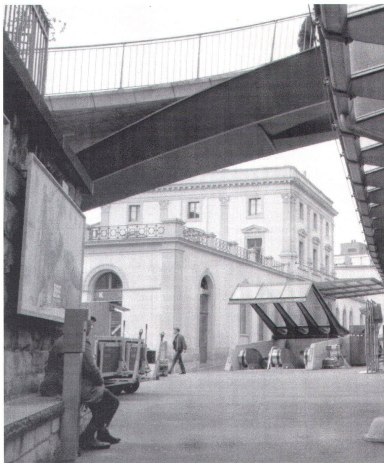
Im Hinblick auf den S-Bahn-Betrieb mussten die SBB den Bahnhof Stadelhofen erweitern. Mit dem Beschwerderecht im Rücken konnte der Heimatschutz eine Lösung erreichen, die sowohl dem Charme des alten Bahnhofgebäudes und dessen städtebaulicher Situation als auch den Bedürfnissen der Bahn gerecht wird (Bild SHS)
