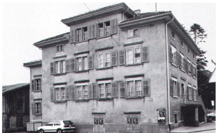
Westseite des ehemaligen Bezirksamtsgebäudes (Bild Gassner) Partie ouest de l'ancien bâtiment officiel du district.
