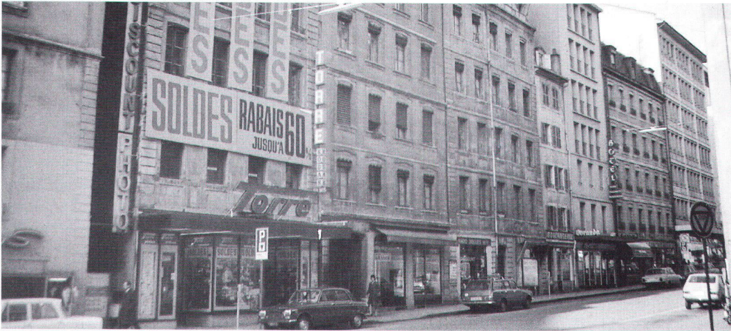
Groupe de bâtiments, rue Rousseau, pour la restauration desquels des moyens financiers sont actuellement recherchés (photo Baertschi).
