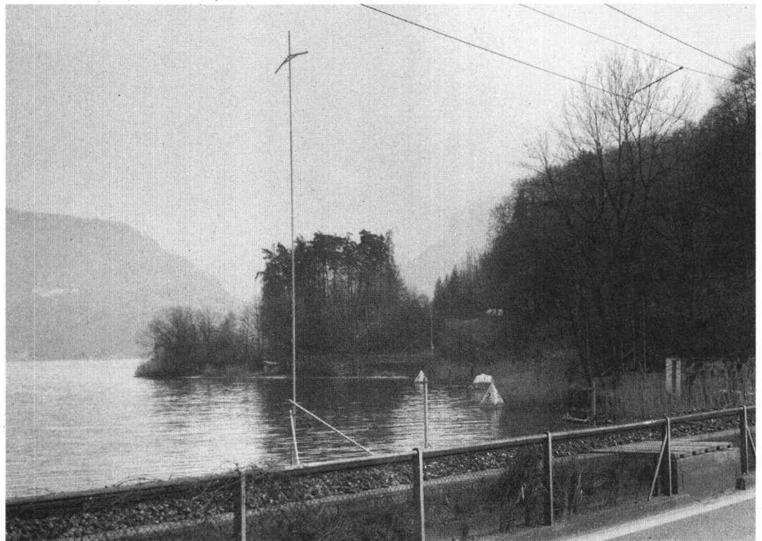
Das Auflageprojekt für den Ausbau der N2 entlang der Bucht bei Horw LU hatte eine Aufschüttung gemäss der im Bild sichtbaren Profilierung erfordert. In Verhandlungen konnten die Heimatschützer erhebliche Verbesserungen erreichen.
