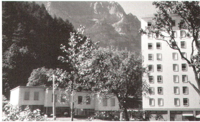
Rechts das Personalhochhaus, links das Ärzteshaus des Kantonsspitals Glarus, die in ihrer Fassadenstruktur hätten wesentlich verändert werden sollen (Bild Glarner Heimatschutz)
