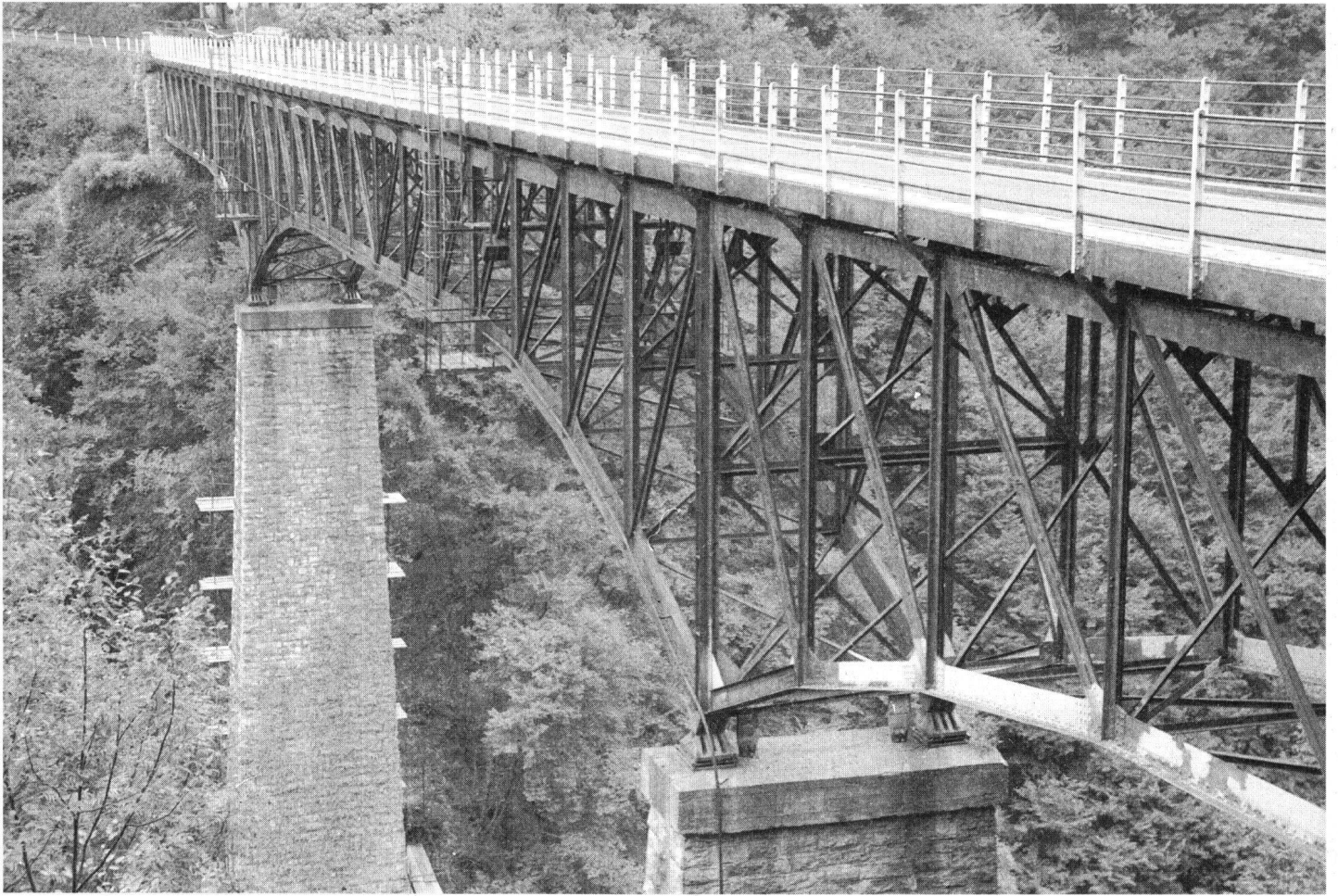
«To be or not to be» ist die Frage für eine der ältesten Eisenbrücken der Schweiz. Der Staatsrat des Kt. Tessin scheint selbst nicht zu wissen, was er (bezahlen) will. Die Brücke spannt sich über eine romantische Schlucht oberhalb Chiasso.
