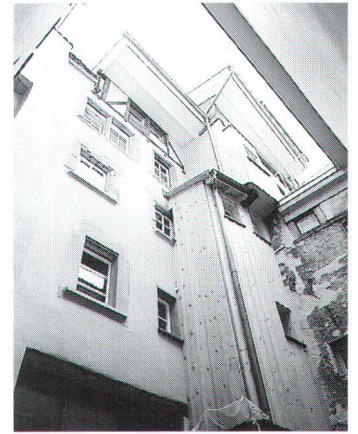
Das Haus Rindermarkt 7 nach der Erneuerung.
