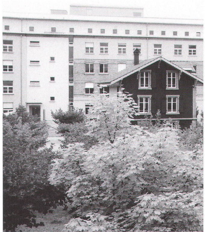
Die umgenutzte Schokoladefabrik Tobler beherbergt heute Teile der Universität Bern. Im kleinen Historismus-Häuschen sind studentische Sekretariate untergebracht. (Bild SHS)
