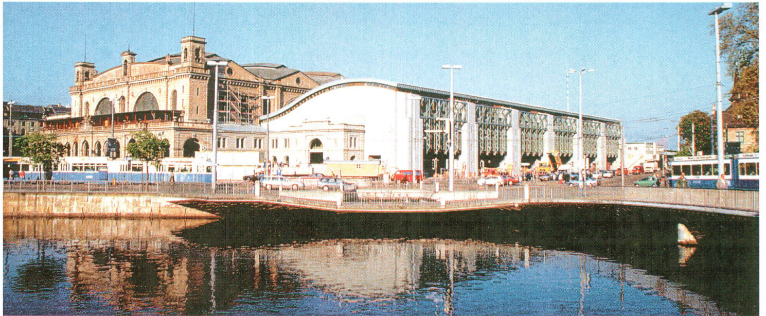
Der neue Nordtrakt des Zürcher Hauptbahnhofes kurz vor seiner Fertigstellung im Jahre 1996. La nouvelle aile nord de la gare de Zurich juste avant son achèvement en 1996.
