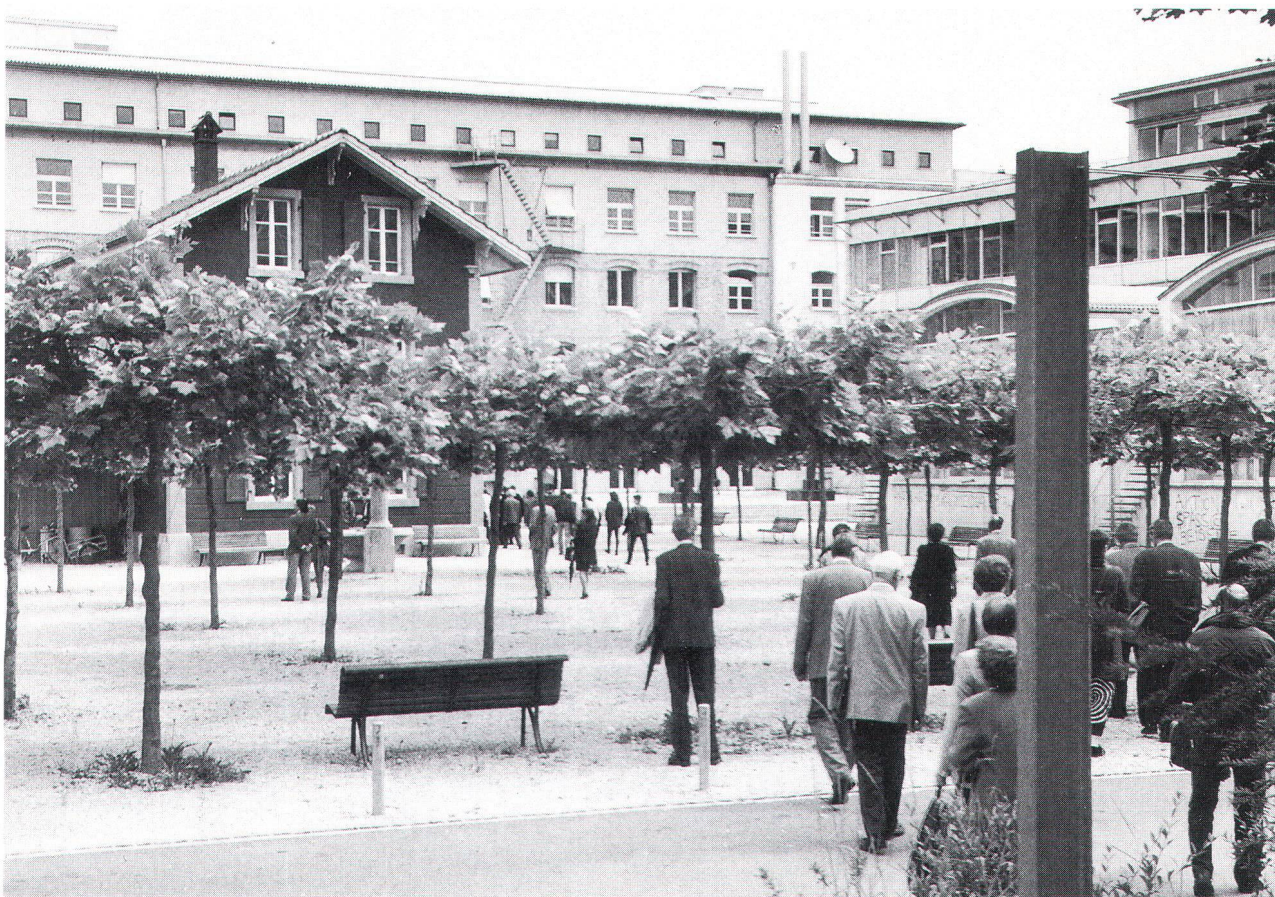
Das Mittagessen der Delegierten fand in der Unitobler statt. Die ehemalige Schokoladefabrik ist eines der prominentesten Objekte, für die die Stadt Bern den Wakker-Preis erhalten hat. Nach der Umnutzung beherbergt sie Seminarien der Universität Bern. (Bild SHS)
