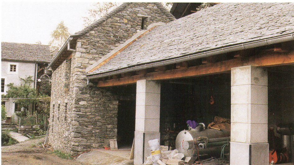
Diese vom FLS mitfinanzierte Sanierung von Ställen und Remisen in Bordei TI zeigt, dass Rücksicht auf regionale Bautraditionen und eine moderne Landwirtschaft zu vereinbaren sind. (Bild Stiftung Terra Vecchia)
