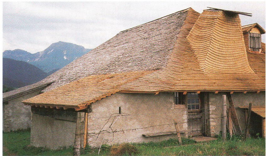
Mit Hilfe des FLS neu verschindelte Alphütten können im Freiburgischen nicht nur wieder genutzt werden, sie tragen auch zur Bewahrung der Kulturlandschaft bei. (Bild Service des biens culturels FR) Grâce au FSP, des chalets d'alpage fribourgeois recouverts de bardeaux neufs sont de nouveau utilisés et contribuent à la sauvegarde des paysages ruraux traditionnels (photo service des biens culturels FR).
