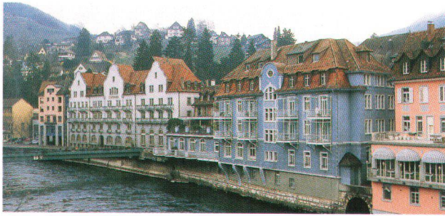
Bäderhotels an der Limmat in Ennetbaden. (Bild SHS) Hôtels des bains au bord de la Limmat à Ennetbaden (photo LSP).
