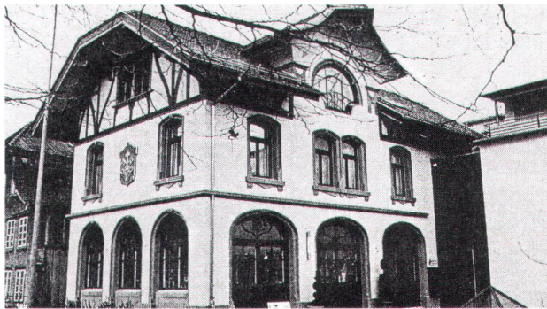
Das Füglistallerhaus in Langenthal – einst Schlosserei, jetzt ein Restaurant. Das hochkarätige Jugendstilhaus konnte dank der Einsprache des Berner Heimatschutzes vor dem Abbruch bewahrt werden.
