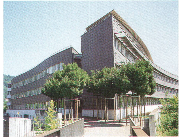
Les bureaux de la société Metron SA de Brugg se distinguent par leur architecture adaptée et une consommation relativement basse d'énergie (photo Badilatti).
