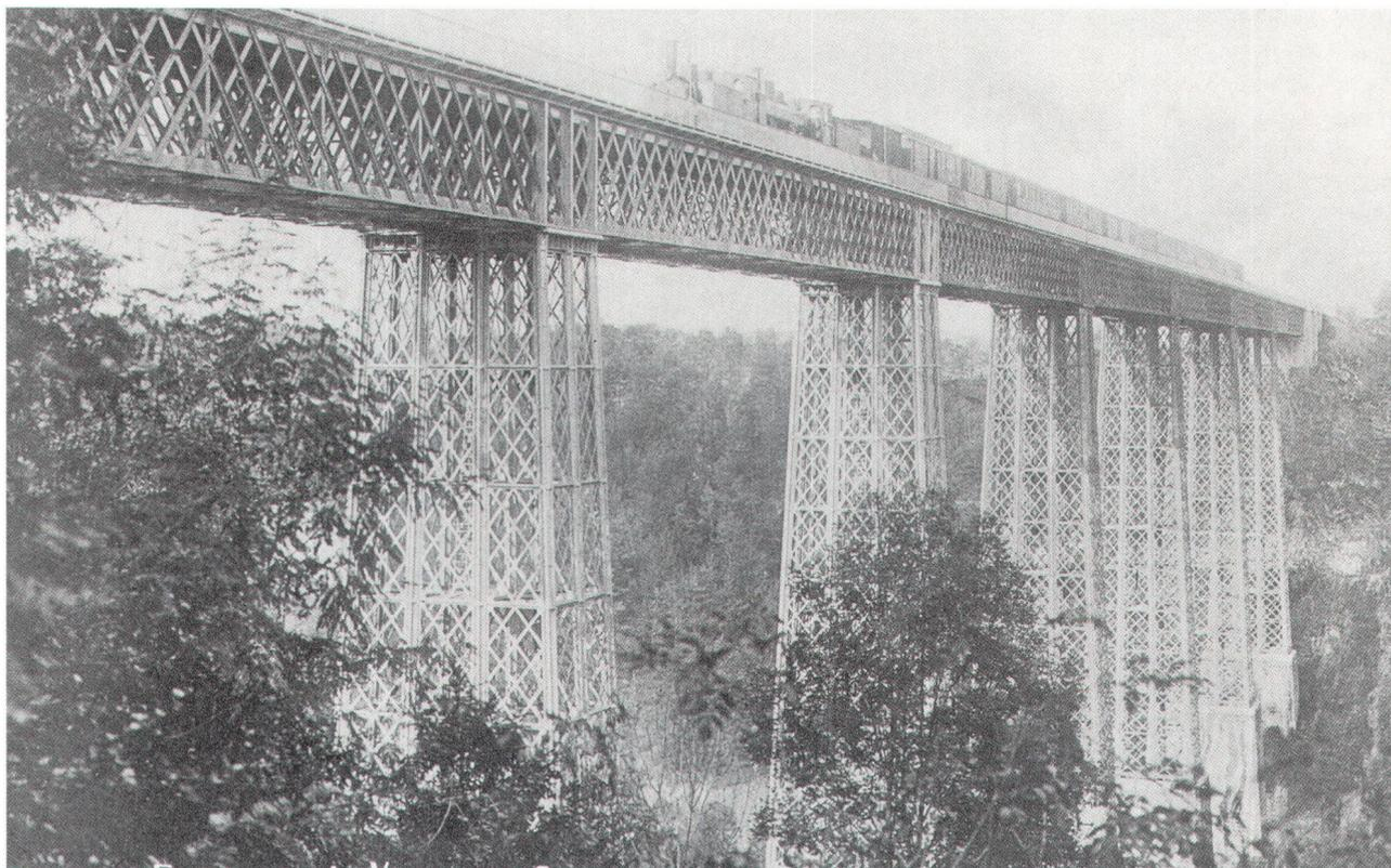
*A l'origine, le viaduc en treillis métallique de Grandfey FR (334 m de long et 80 m de haut) reposait sur des socles en blocs de molasse ... (photo CFF)*
