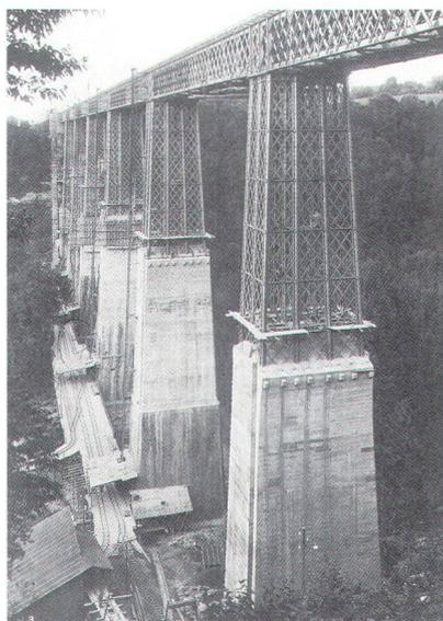
*... en 1925/27, afin d'améliorer durablement la solidité de l'ouvrage, on bétonna les piles métalliques jusqu'à mi-hauteur ... (photo CFF)*
