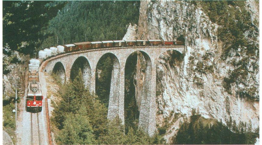
Der steinerne und 65 m über dem Talboden liegende Landwasserviadukt (1901/1902) ist die spektakulärste Brücke der Albulalinie. (Bild Rhätische Bahn) *Le viaduc en maçonnerie (1901/1902) qui enjambe la Landwasser à 65 m de hauteur est l'un des ouvrages les plus spectaculaires de la ligne de l'Albula (photo chemins de fer rhétiques).*
