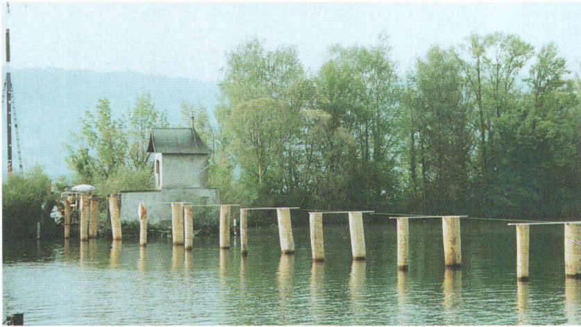
Historisches Vorbild (Bild rechts) und Tragpfähle des künftigen Fussgänger-Holzstegs von Rapperswil nach Hurden. (Bilder Rathgeb) Référence historique (photo de droite) et piliers de la future passerelle en bois entre Rapperswil et Hurden (photos Rathgeb).
