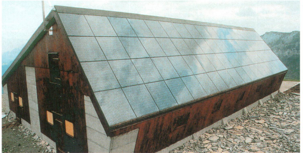
Die Einkleidung eines Daches mit Solarzellen wird bei der Alp Findels ob Pfäfers SG als eigenes gestalterisches Element wahrgenommen. (Bild TNC Consulting AG) La pose de cellules photovoltaïques sur le toit de l'alpage Findels au-dessus de Pfäfers SG est un élément architectural en soi (photo TNC consulting AG).
